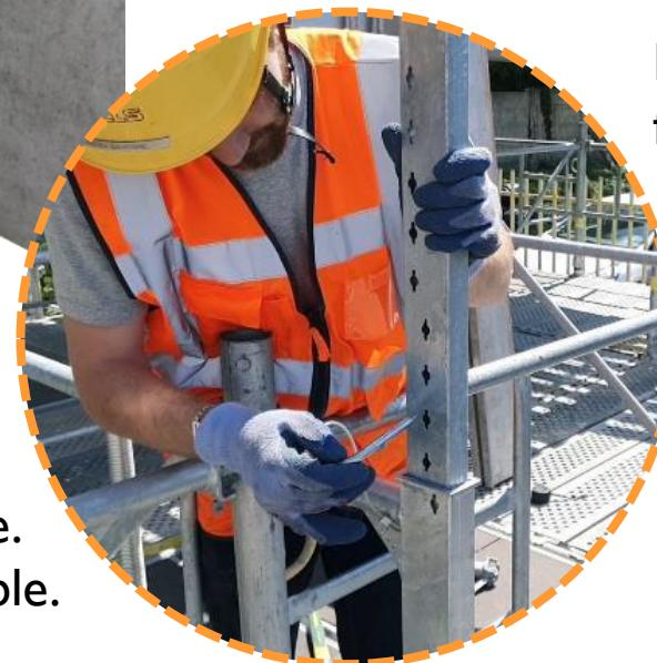
Le marquage d'un trait de niveau facilite le réglage. Des lumières verticales sur la coulisse permettent un ajustement rapide de la coulisse avec le niveau du futur coffrage.
