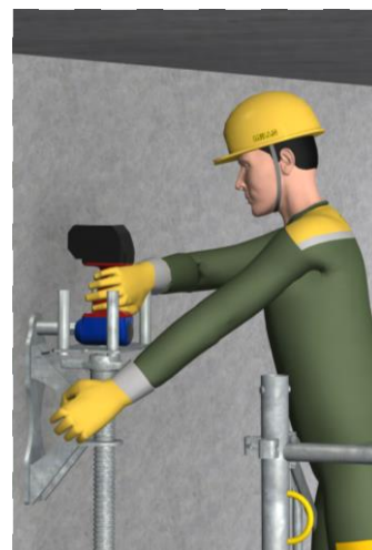
Dépose du corbeau 2,5T
