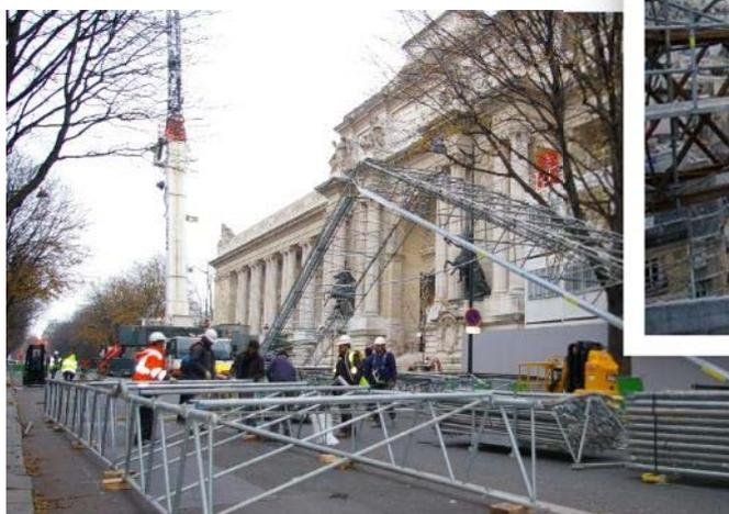
*Les fermes CK800 sont assemblées au sol puis les caissons sont posés sur les H33 avec une grue de 200 tonnes.*
