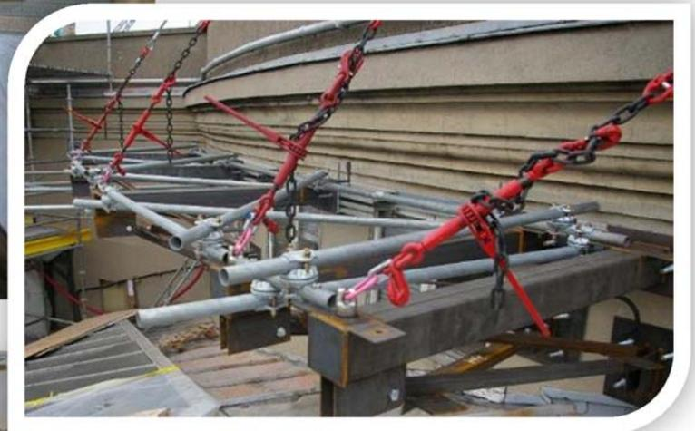
*Système d'amarrage par câble et par ancrage traversant*
