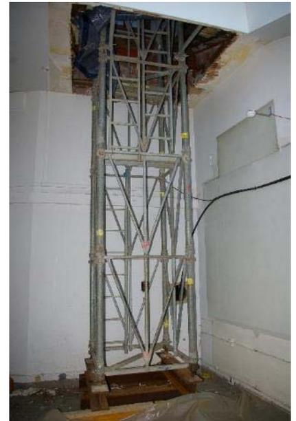
*La charpente est en appui sur des Mills Tour traversant la toiture.*
