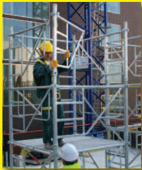
Touréchaf pour le clavetage des poutres de la toiture de la Philharmonie de Paris.
