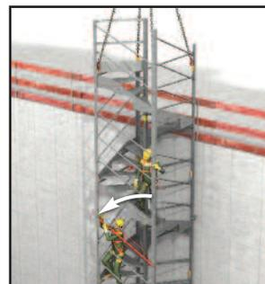
> **11** - Den 3. Handlauf auf Seite A anbringen. Vor Abnehmen des Seilgeschirrs sicherstellen, dass die Verankerungen installiert sind.
