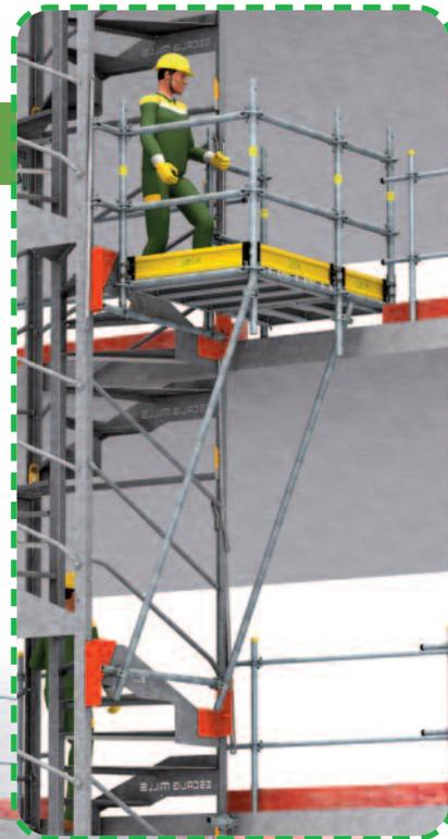
Der Konsolenlaufsteg wird von 2 Röhren  $\varnothing 49$  gestützt, die auf der unteren Ebene mit einem 1,50 m langen, mit den 2 "Laufstegträgern" verbundenen Gerüströhr befestigt sind.
