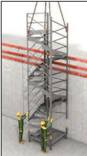
> **8** - Einheit auf die Grundplatte aufsetzen und die 4 Holme mit M24 Schrauben befestigen.
