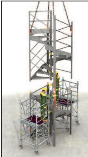
> **5** - Einheit auf ein neues Standardmodul aufsetzen, den Handlauf Seite B dabei mitführen. Die 4 Holme mit M24 Schrauben befestigen.
