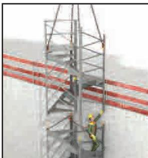
> **9** - Zugang in Escalib Mills mit eingehaktem Sicherheitsgurt auf der oberen Traverse. Das letzte Standardmodul aufsetzen und die 4 Holme mit M24 Schrauben befestigen.
