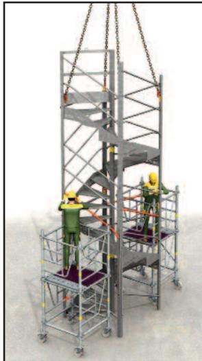
> **6** - Die 3 Handläufe über die 2 Standardmodule anbringen. Schritte 4, 5 und 6 bei Bedarf wiederholen.
