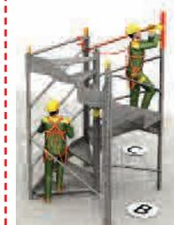
> **6** - Mit auf der oberen Traverse eingehängtem Sicherheitsgurt den kleinen Pfosten auf die Ecken der Seiten C und B aufschrauben befestigen. Mit M24 Handlauf anbringen.
